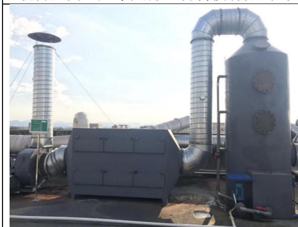
现有工程废气排放口 FQ-G1（水喷淋塔+除湿除雾+活性炭处理装置）
