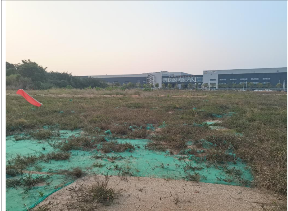
储能电站现状
