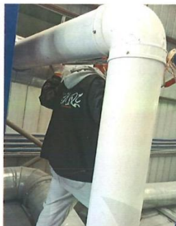
配料、混合工序废气处理前监测口
