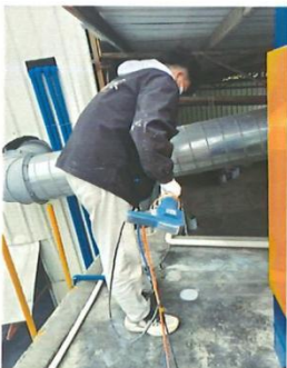
挤出工序废气处理前监测口
