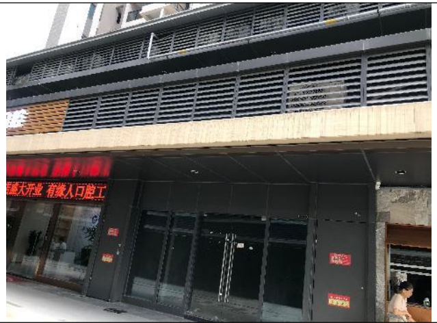
项目所在一楼商铺-108房
