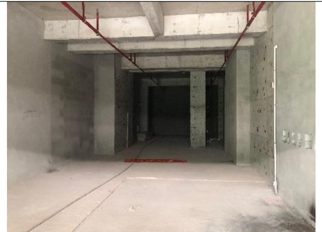
项目内部现状
