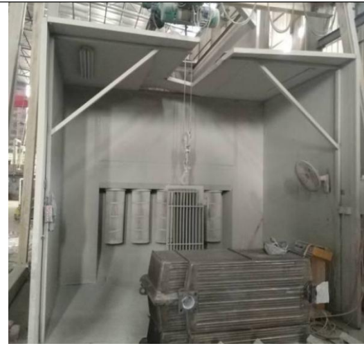
静电喷涂工序废气治理设施
