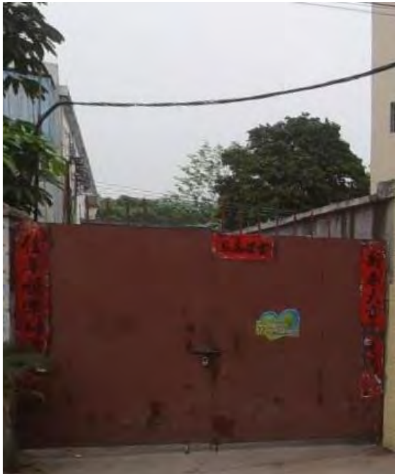
项目东侧：工业厂房
