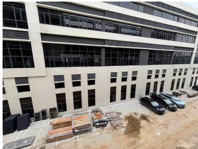
项目南面（在建不知名厂房）
