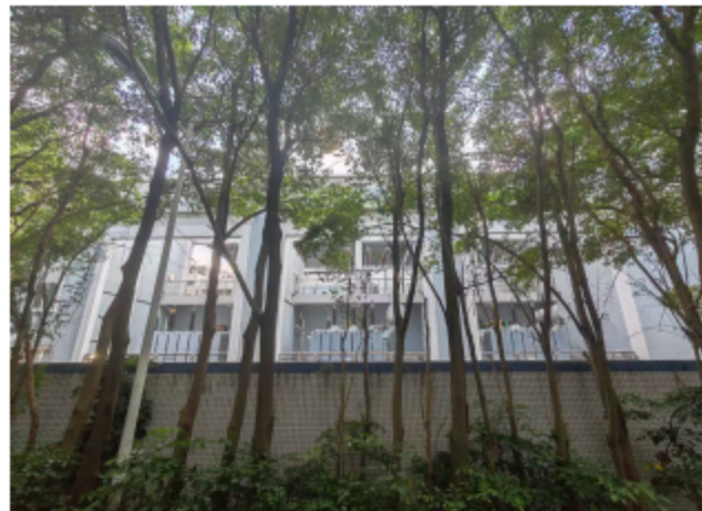
南面：110kV 加庄变电站
