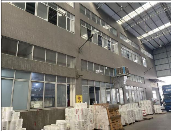
本项目所在工业厂房（1楼）
