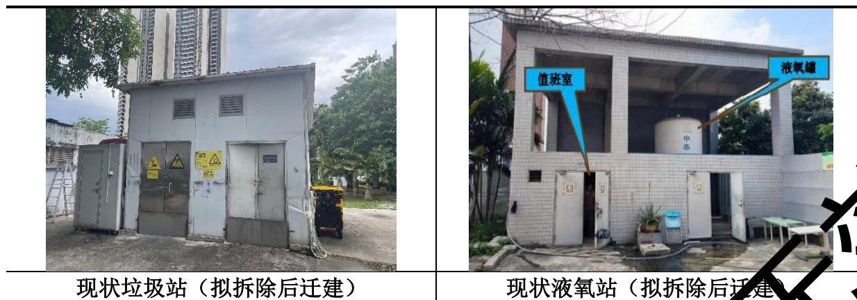
图 4.1-1 项目选址现状照片
