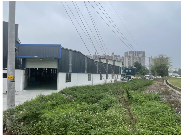
厂界西面-广州杉木汽车科技有限公司
