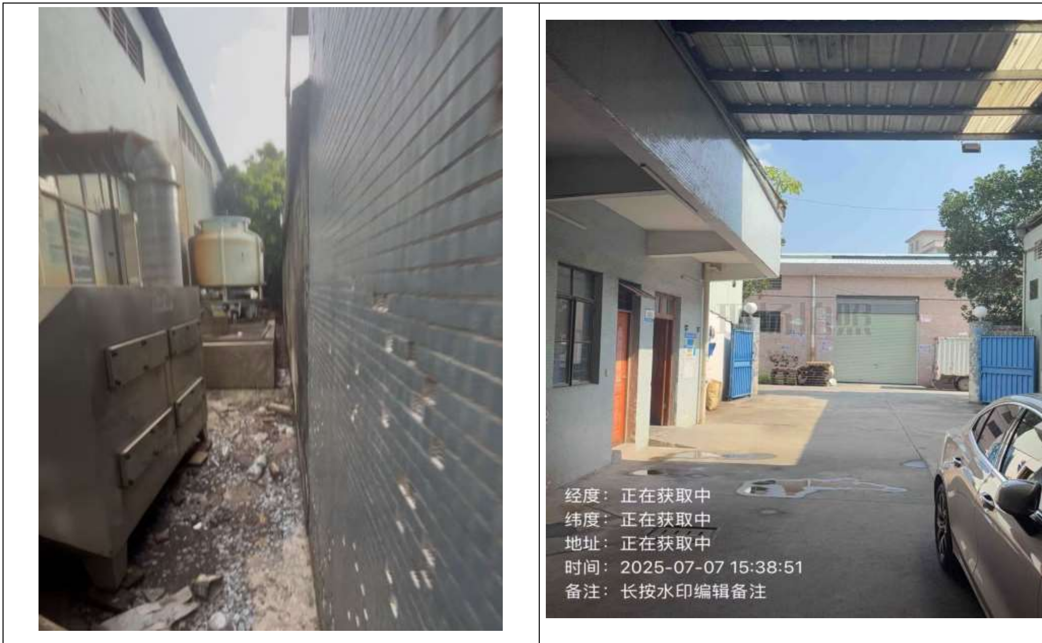
附图 16 现场勘查照片
