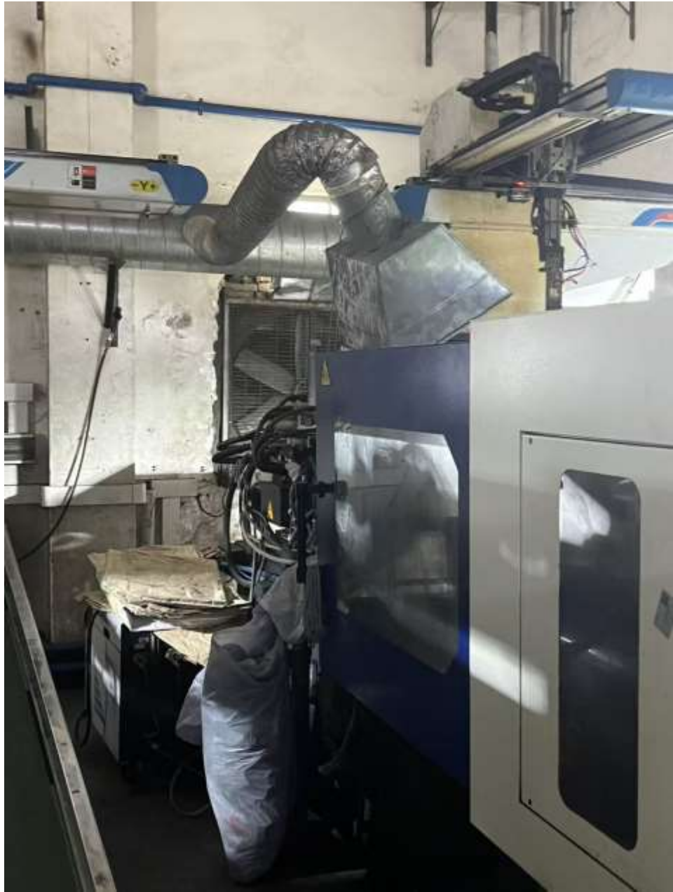
图 4-1 废气收集照片
