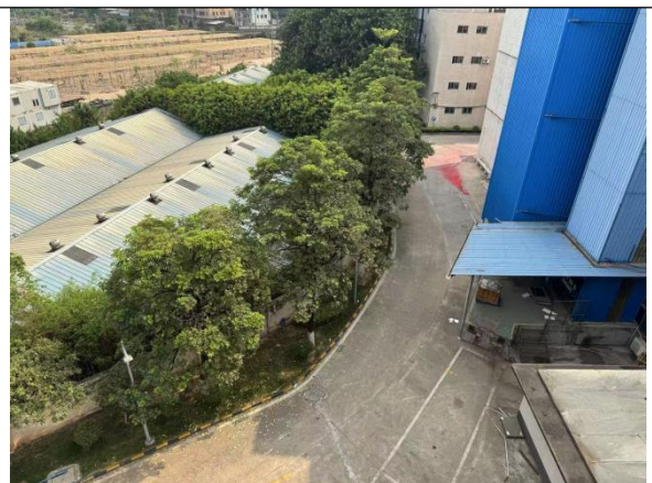
项目南面-空地及其他工业厂房
