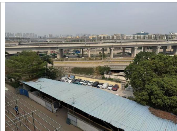
项目东面-园区空地
