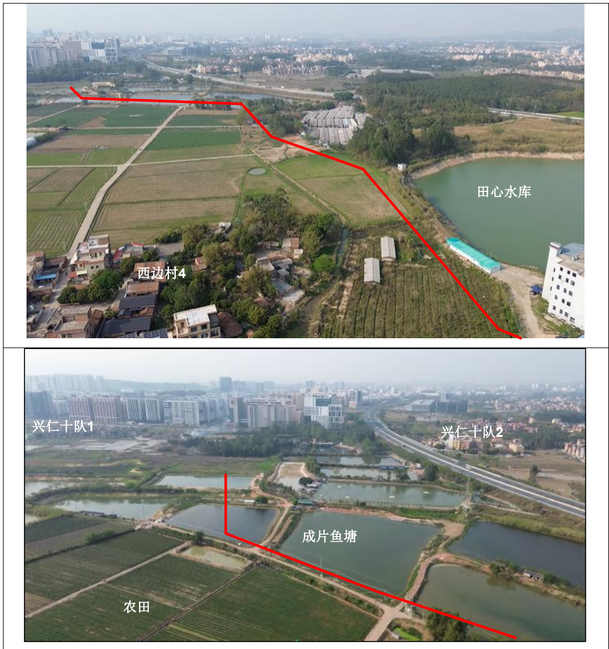
专图4.2-1 本项目管线沿途生态环境现状实拍图
