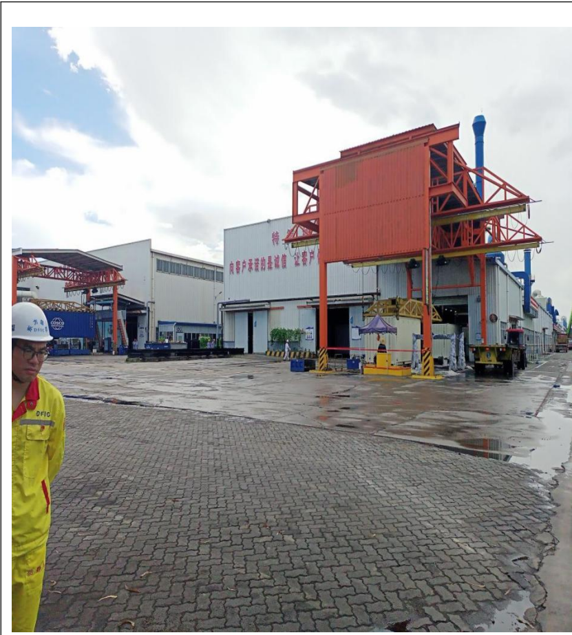
西侧：特箱生产线厂房
