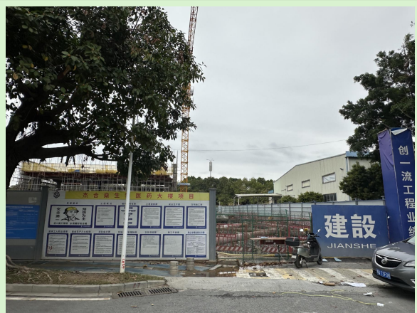
项目南面：在建厂房
