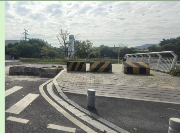
项目东面：空地
