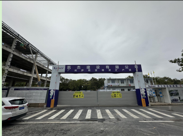
项目南面：在建厂房
