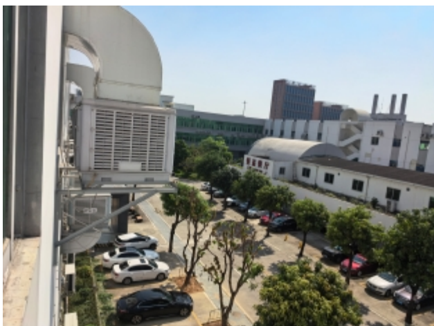
西面隔园区道路为恒益餐厅
