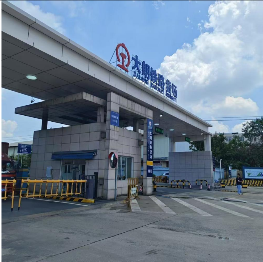
大朗铁路货场南门入口现状
