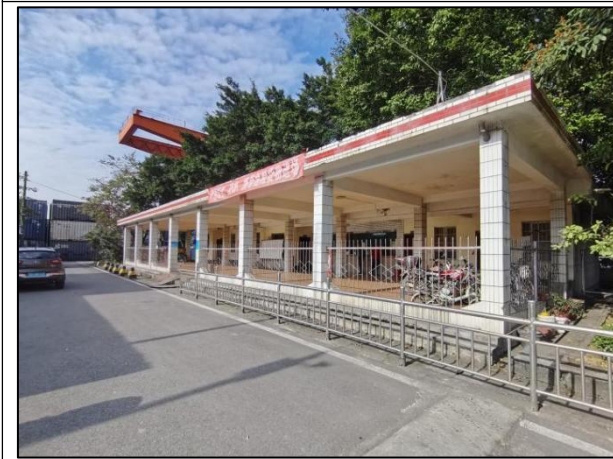
安检仪库房东南侧办公区现状
