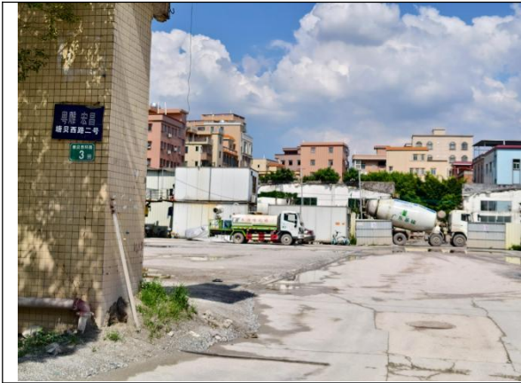
东面：在建厂房
