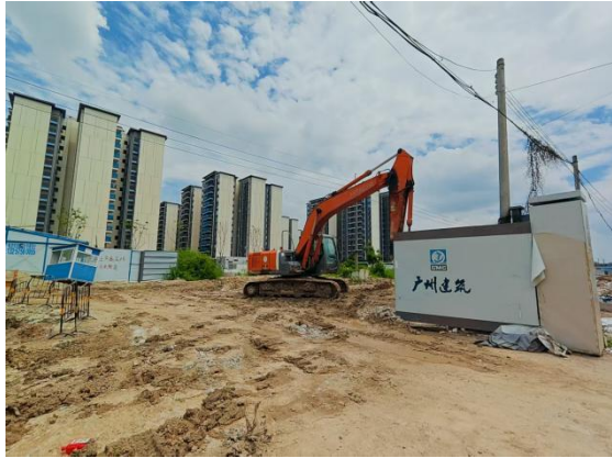
东面：工地、在建居民楼
