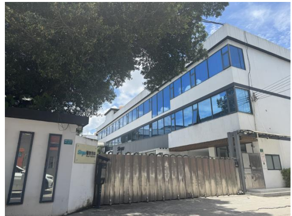
项目北面--馨誉香料(广州)有限公司
