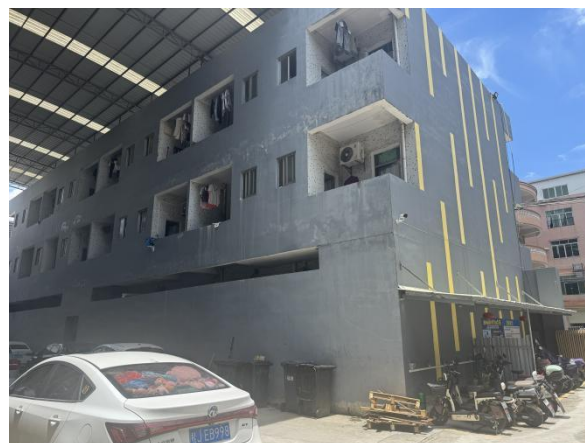
项目东面--园区内宿舍楼
