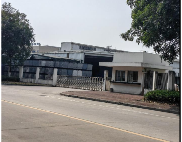
项目西南面：广州西川密封件有限公司
