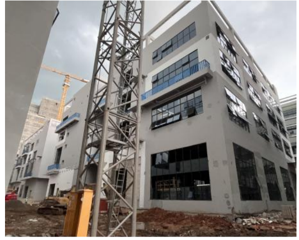
项目南面（12米）：园区内5#栋厂房
