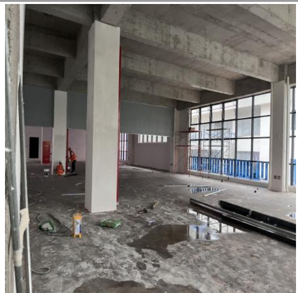
项目厂房现状（2）
