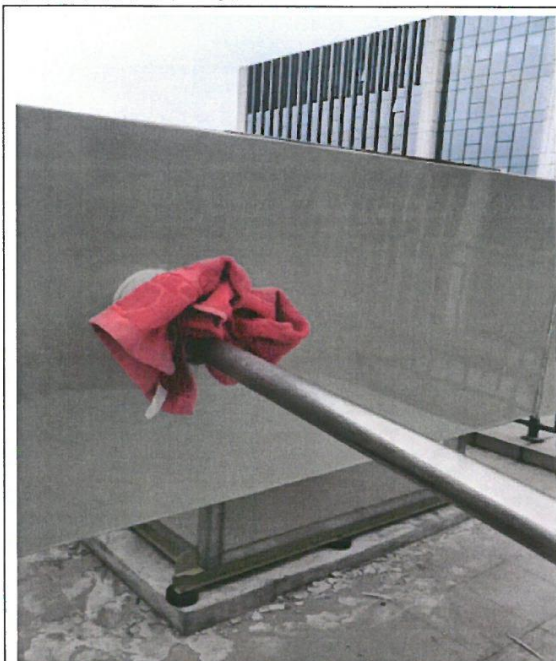
图 9.5 投料、研发制样、检测废气处理后检测口 Q2
