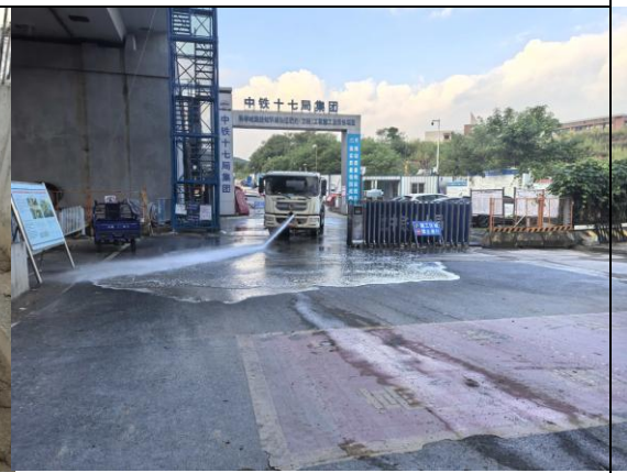
图 5-2 施工期大气污染防治措施照片
