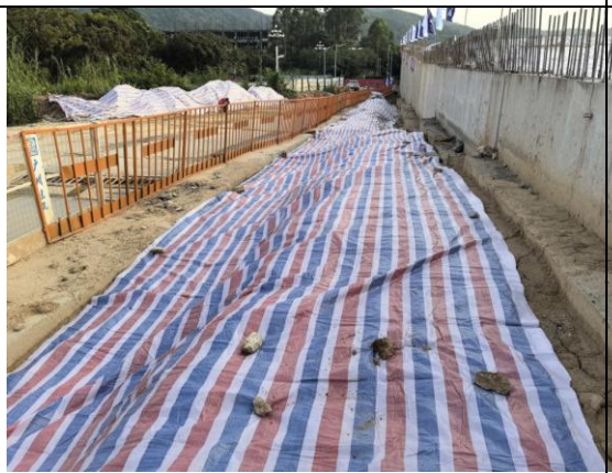
图 5-2 施工期大气污染防治措施照片
