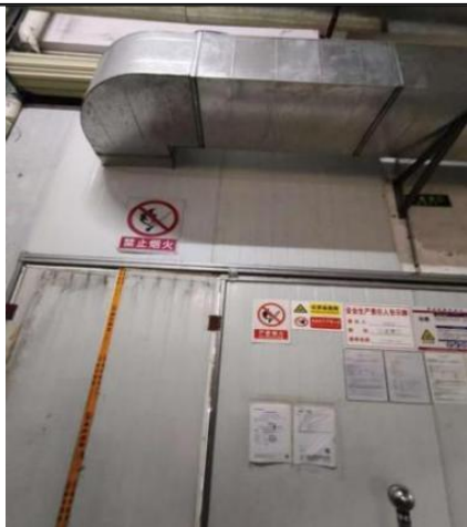
图 2-8 厂房 C1 排气筒 FQ-20270-1 收集废气图
