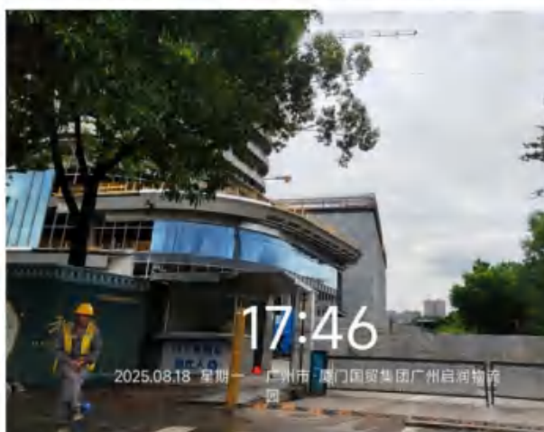
项目西面 在建工地
