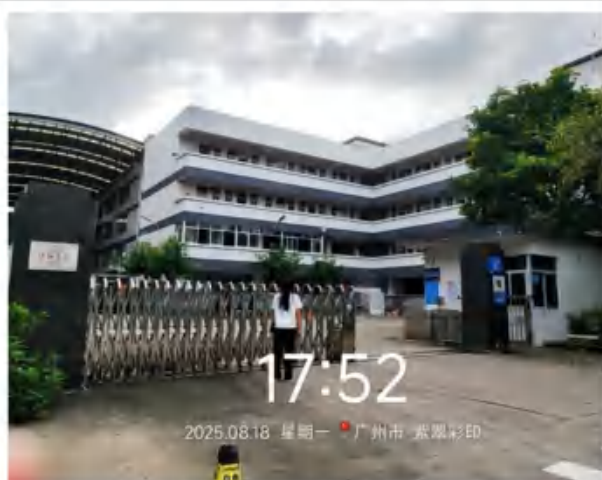
项目北面 广州天盛印刷有限公司
