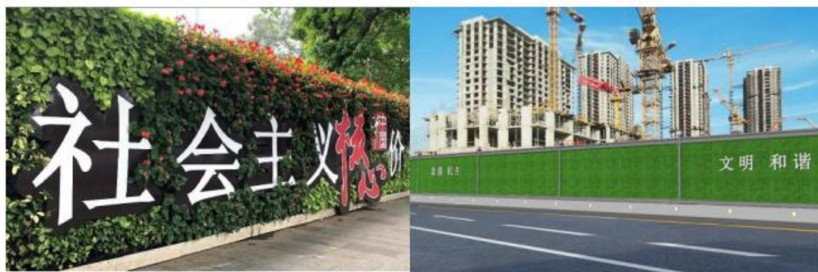
图 3.14-2 立体绿化围蔽仿真绿植围蔽
