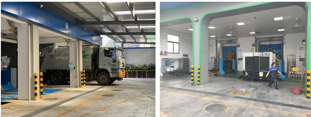
压缩大厅及压缩仓区（可见地面防腐防渗涂层及废水收集沟及收集井）
