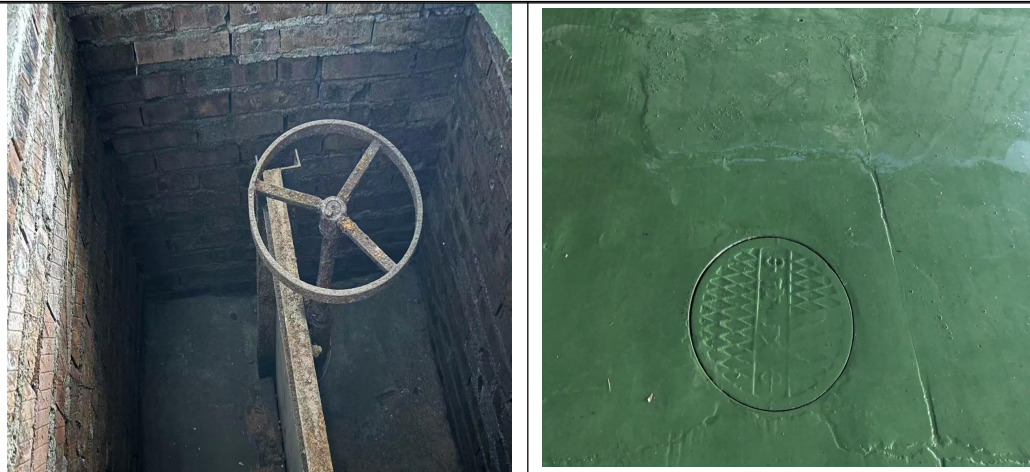
图 4-6 本项目雨水阀门
