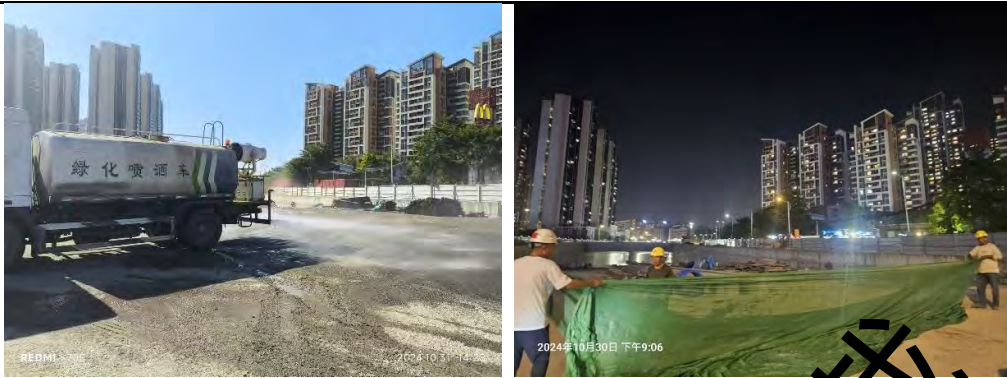
图 5-1 施工期大气污染防治措施照片
