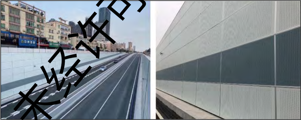
图6.2-1 隧道吸音板示意图
