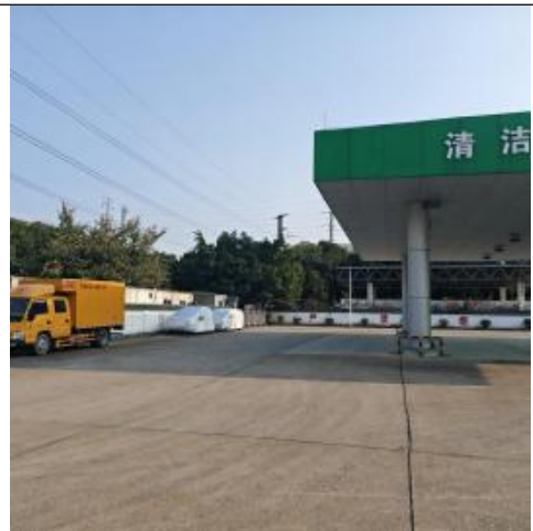
项目现场：拟增设加油设施区域
