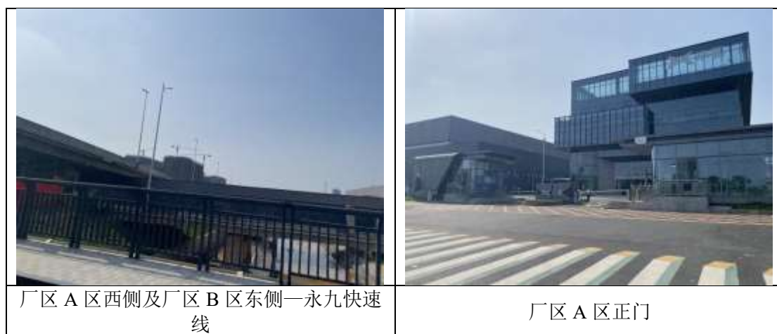
图 4.1-2 项目四至情况实景图
