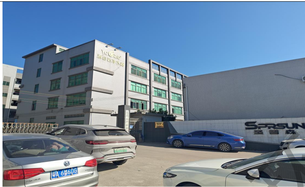
项目东面-工业厂房
