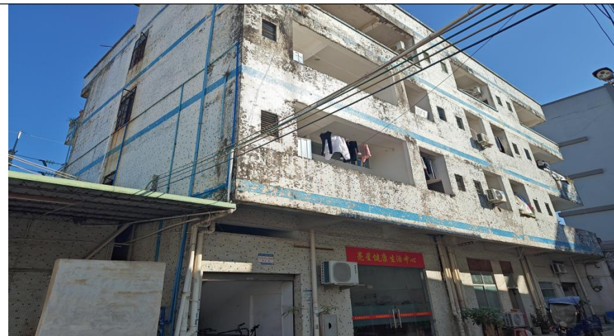
项目北面-工业厂房
