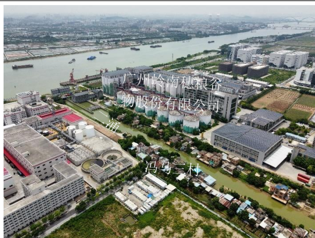
项目西北侧现状照片
