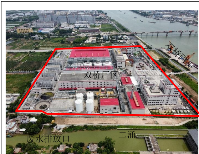
项目厂区现状照片
