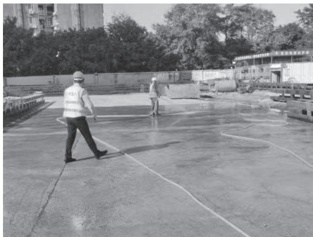
施工单位落实裸土覆盖和洒水降尘
