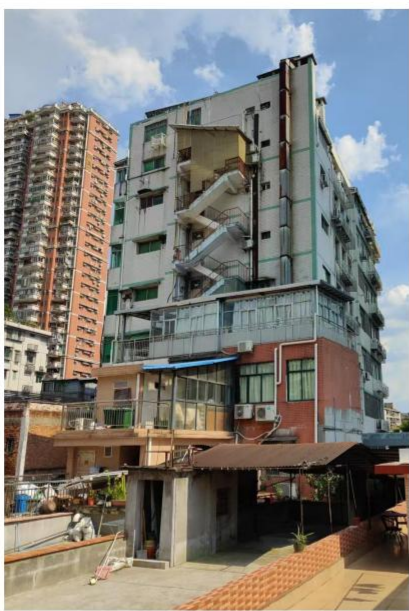
储物楼东面（主楼）
