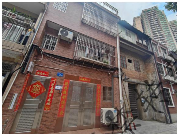
储物楼东面（居民楼）
