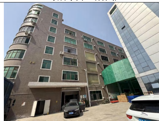
项目北面：园区 E 栋厂房
