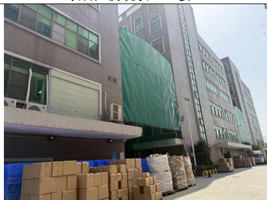
项目南面：园区 C 栋厂房
