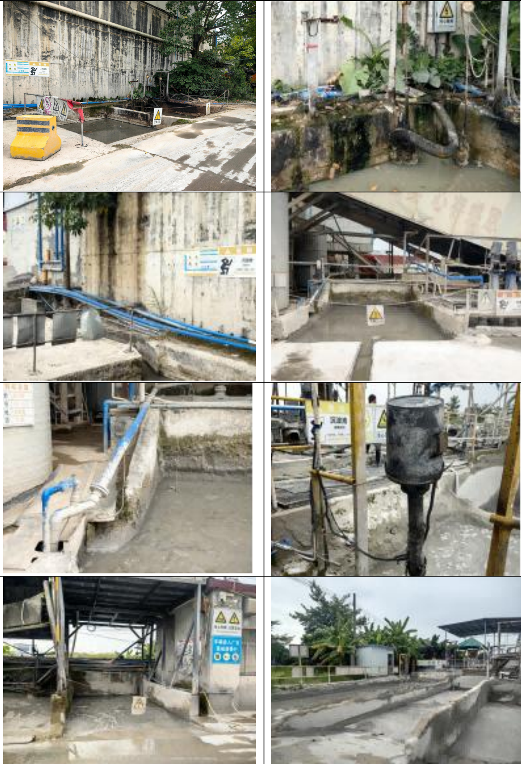
三级沉淀池及配套的管网、水泵等现场照片
