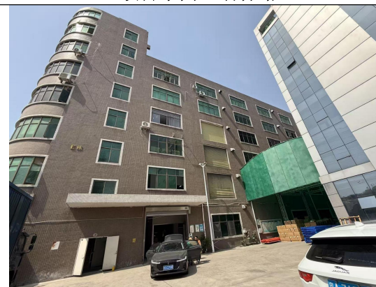
项目北面：园区 E 栋厂房
