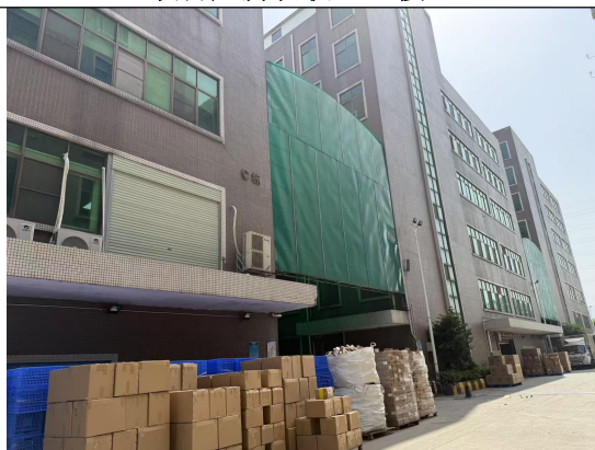
项目南面：园区 C 栋厂房
