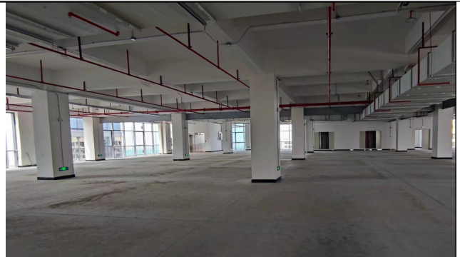
建设项目 4 栋 401 车间
