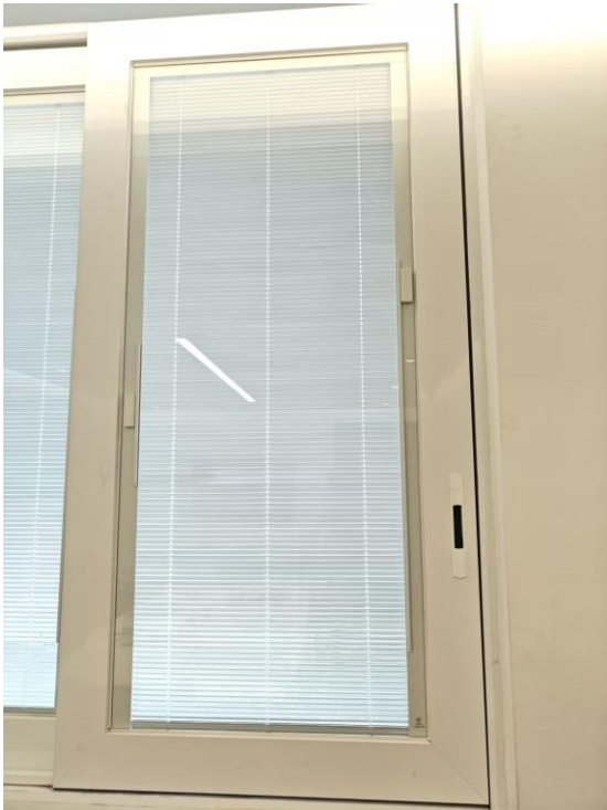
BBG内置了百叶的中空玻璃窗照片
