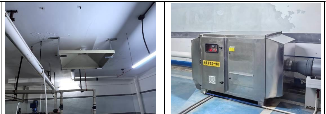
图 2-6 污水处理间废气处理设施照片
