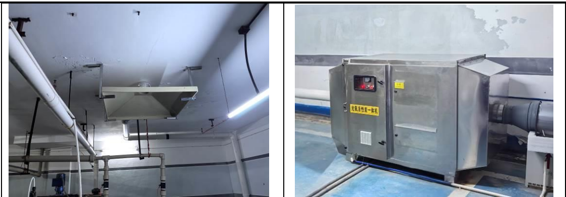
图 4-3 现有工程污水处理间废气处理设施照片
