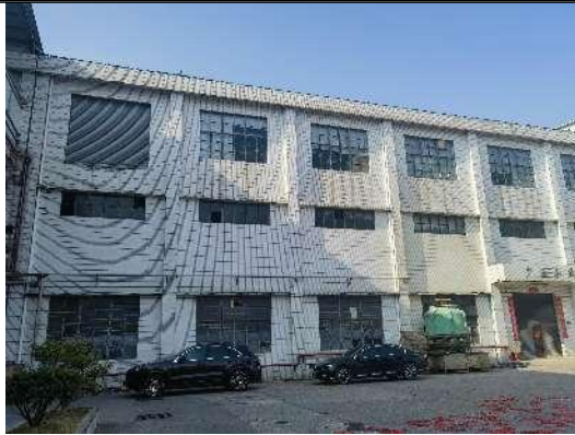
项目东北面-广州市永盛包装制品有限公司
