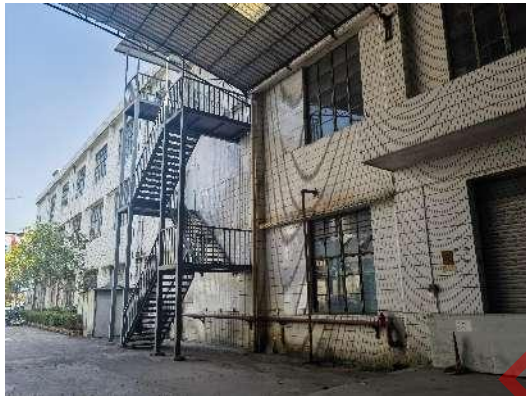
项目东南面-工业厂房和广州市锦盛生物科 技有限公司
