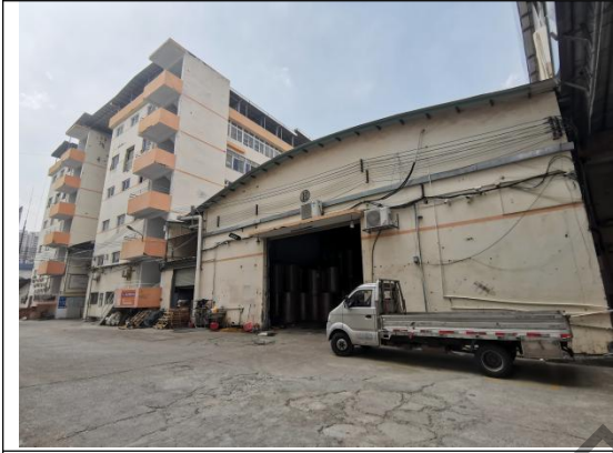
东北面：B 栋和 E 栋厂房
