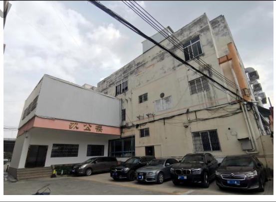
西北面：D 栋厂房
