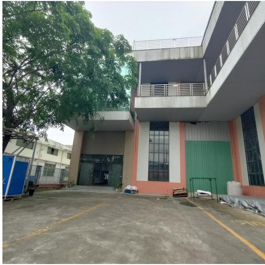
项目西面-空厂房
