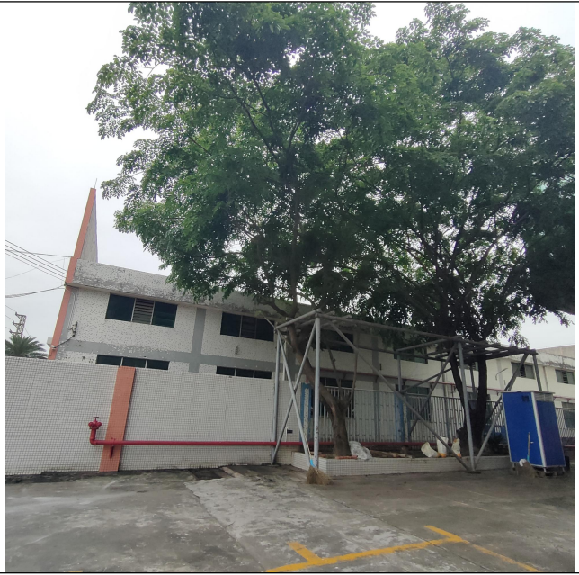
项目南面-停车场
