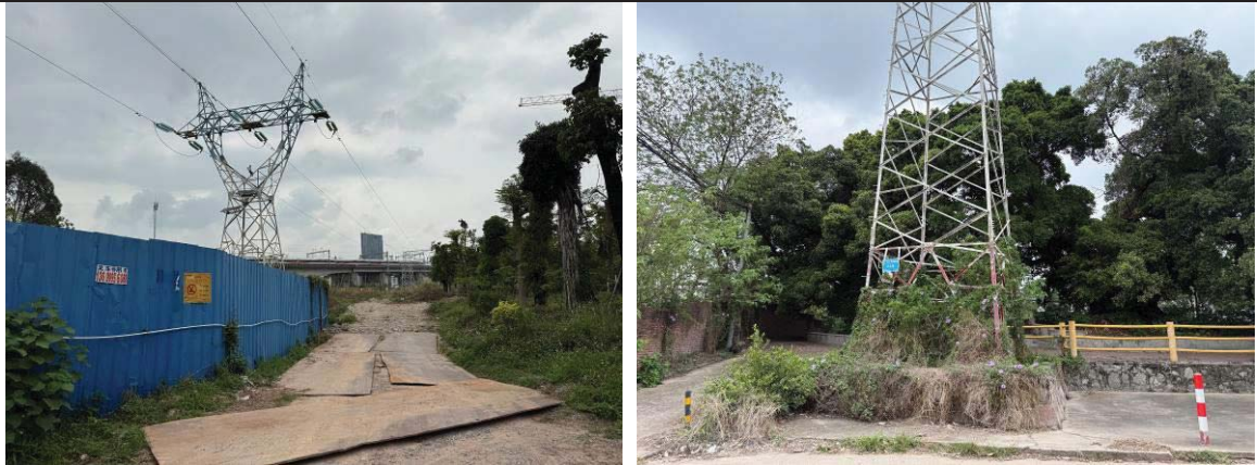
图 3-8 原有架空线路沿线环境现状及塔基绿化情况
