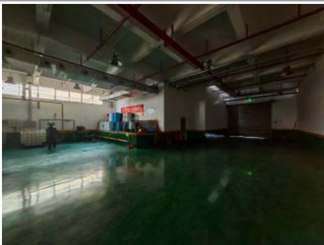
项目厂房情况
