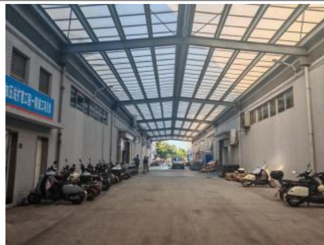
项目厂房情况-卸货区
