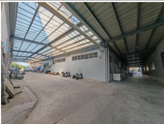
项目厂房情况-卸货区
