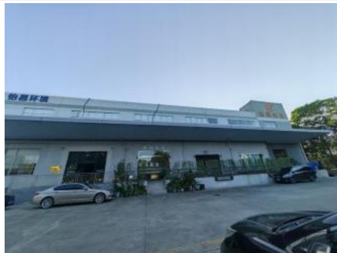
西北面-广东朗固实业有限公司
