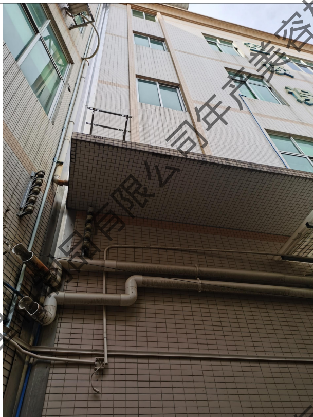
项目西侧厂房
