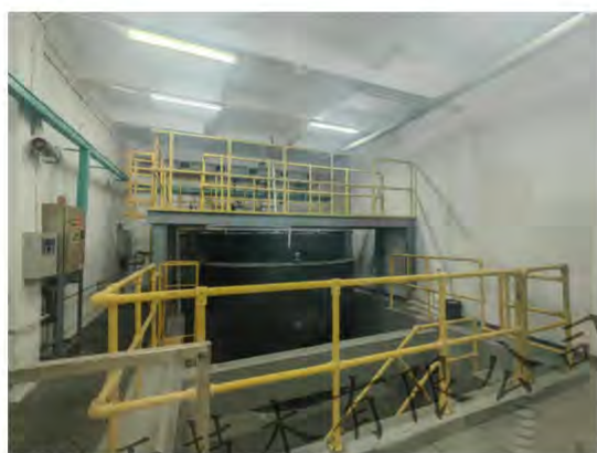
氢氟酸储罐区围堰
